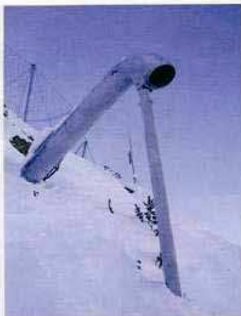
Bewährt: Die Zündrohre ragen 3,5 bis vier Meter über das Gelände hinaus.
